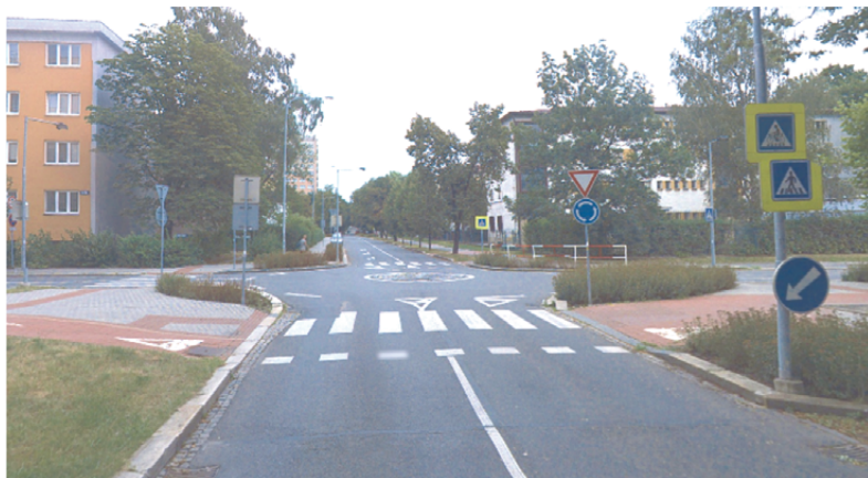
Ryc. 4. Widok dojazdu do mini ronda z drogi zachodniej.
