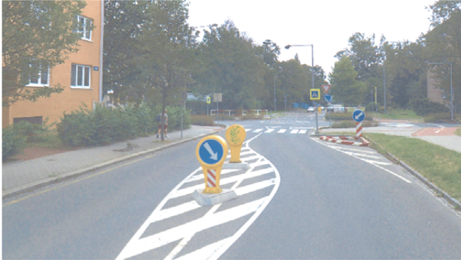
Ryc. 5. Widok dojazdu do mini ronda z drogi północnej.
