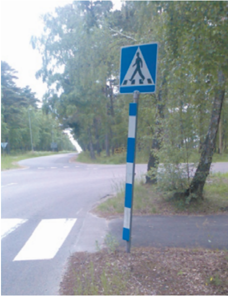
Ryc. 6. Wzmocnienie przekazu płynącego ze znaku D-6 poprzez umieszczenie na słupku elementów odbłaskowych tego samego koloru co znak.
