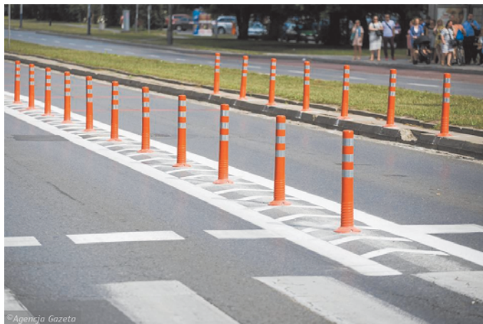
Ryc. 11. Słupki elastyczne przed przejściem dla pieszych.
