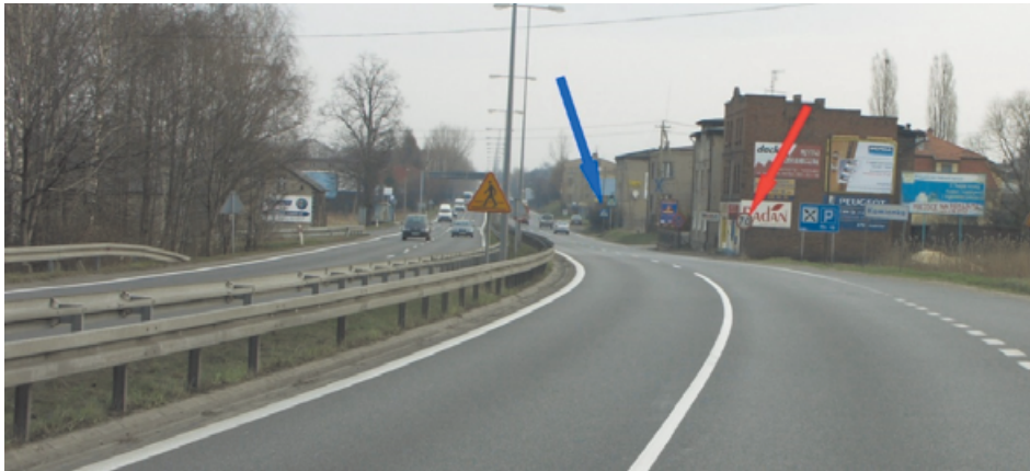
Ryc. 15. Brak wyróżniania się znaków najważniejszych na tym odcinku drogi: ograniczenia prędkości do 70 km/h (czerwona strzałka) i przejście dla pieszych (niebieska strzałka).
