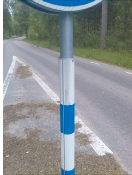
Ryc. 6. Wzmocnienie przekazu płynącego ze znaku D-6 poprzez umieszczenie na słupku elementów odbłaskowych tego samego koloru co znak.
