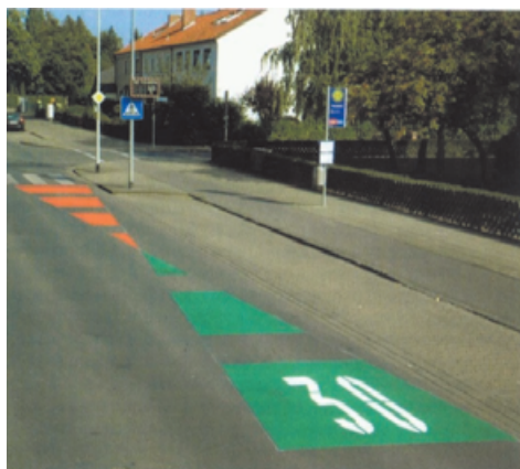
Ryc. 10. Wymalowanie informacyjne przed przejściem.
