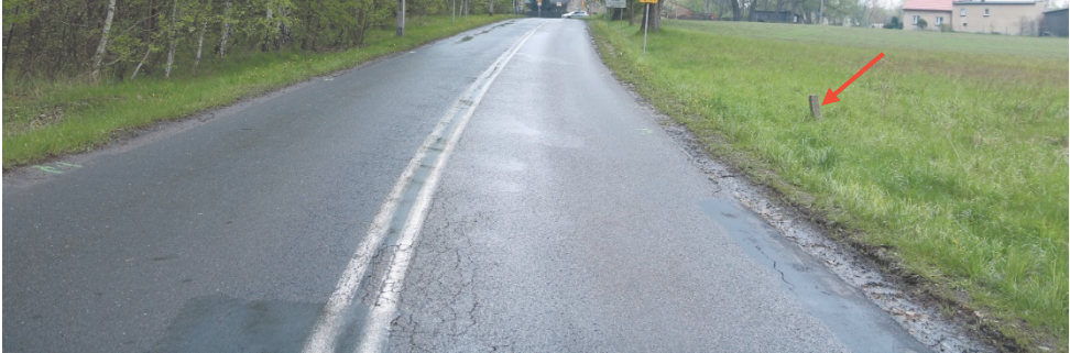
Ryc. 8. Widok z miejsca kierowcy samochodu Audi, na prawym poboczu widać wystający z trawy betonowy słupek.
